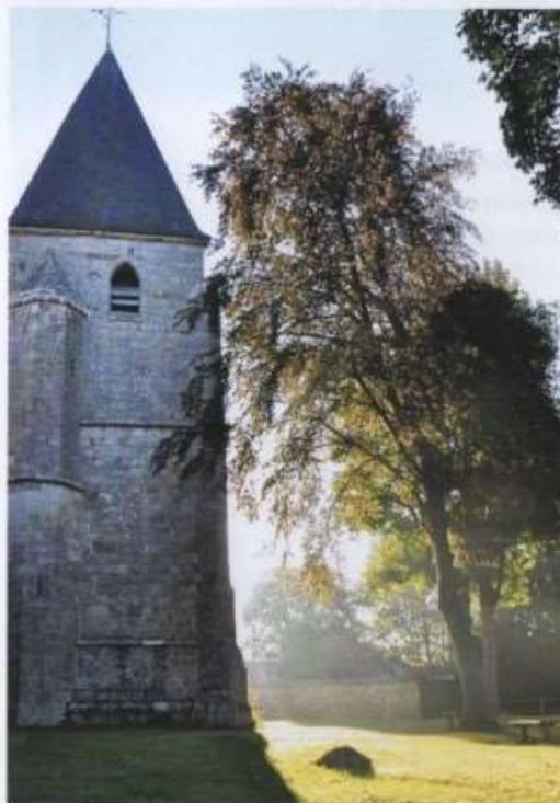
LES TRAVAUX sont prévus pour 2018. La première tranche consiste à refaire la couverture avec un voligeage plus conséquent et une ardoise plus épaisse. À cette occasion la charpente sera réparée, le beffroi révisé ainsi que la cloche. L'ensemble des parements de façade sera nettoyé et rejointé.
